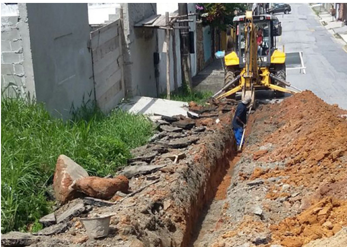
Parque das Palmeiras e Balneário terão rede de esgotamento sanitário e nova ETE
