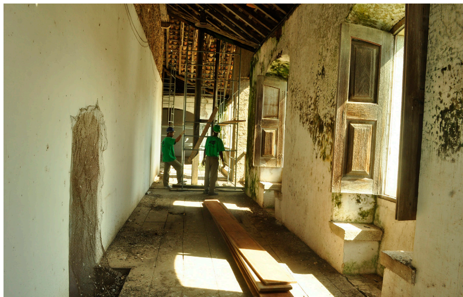
Obras de conservação, descupinização e restauro são frentes de atuação da Direção de Patrimônio da Fundação Cultural de Angra
