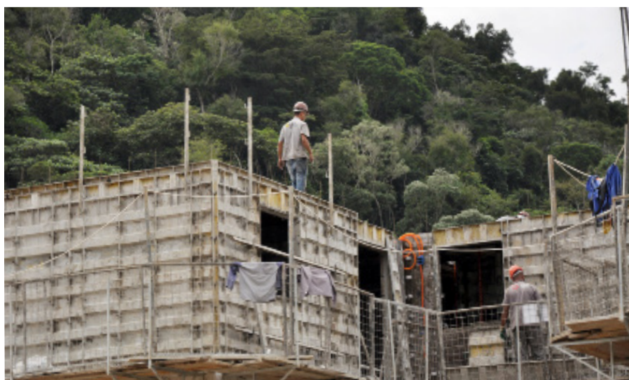
Prefeitura garantiu o andamento das obras
