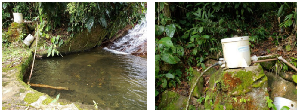
FIGURA 5-63 – BARRAGEM DE ACUMULAÇÃO DO SAA NOVA BANQUETA
