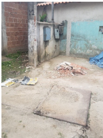
FIGURA 6-79 – EEE PALMIRA – VISTA GERAL
