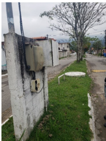
FIGURA 6-36 – EEE 03 – VISTA GERAL
