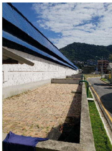
FIGURA 6-130 – ETE PRAIA DA CHÁCARA – LEITOS DE SECAGEM
