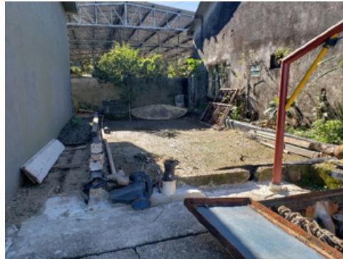
FIGURA 6-201 – ETE ABRAÃO – LEITO DE SECAGEM
