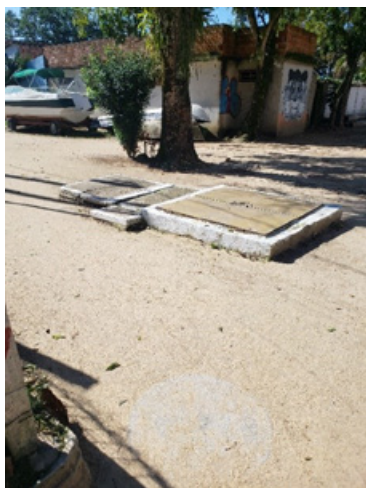
FIGURA 6-194 – EEE 02 – VISTA GERAL
