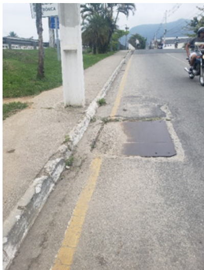
FIGURA 6-83 – EEE AREAL – VISTA GERAL
