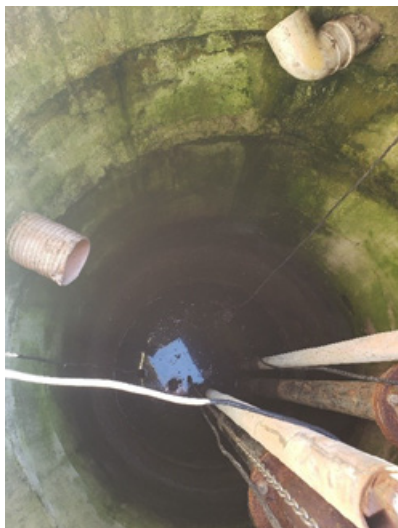
FIGURA 6-205 – ETE PROVETÁ – EEE
