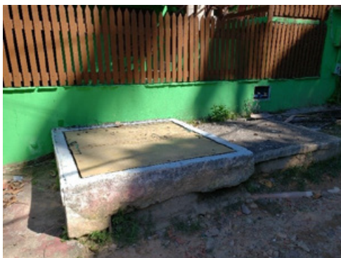
FIGURA 6-182 – EEE 06 – VISTA GERAL
