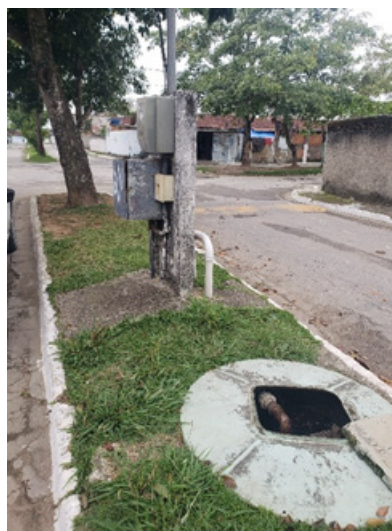
FIGURA 6-39 – EEE 04 – VISTA GERAL
