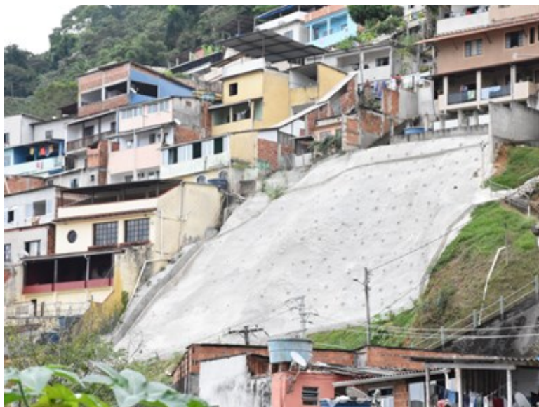
FIGURA 7-3 – OBRA DE CONTENÇÃO DE ENCOSTA NO MORRO DA GLÓRIA I
