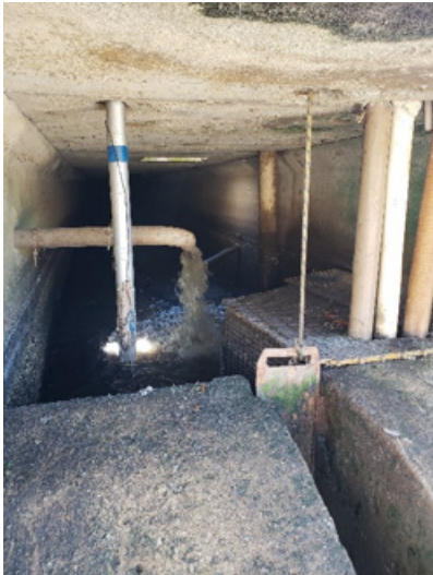
FIGURA 6-108 – EEE ANIL - POÇO DE SUCÇÃO COM GRADEMETNO
