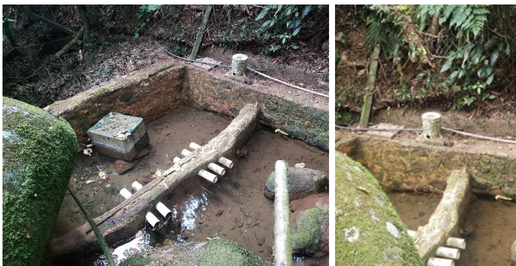
FIGURA 5-22 – BARRAGEM DE ACUMULAÇÃO DO SUBSISTEMA PRAIA VERMELHA
