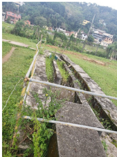
FIGURA 6-52 – ETE FRADE – TRATAMENTO PRELIMINAR
