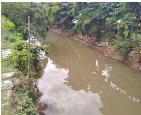
FIGURA 7-19 – VISTA DO CANAL DO RIO DO MEIO
