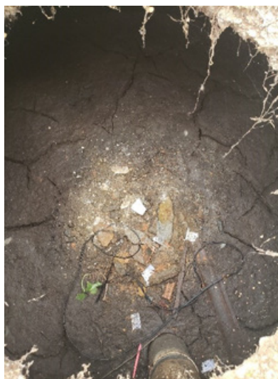
FIGURA 6-33 – VISTA INTERNA DA FOSSA
