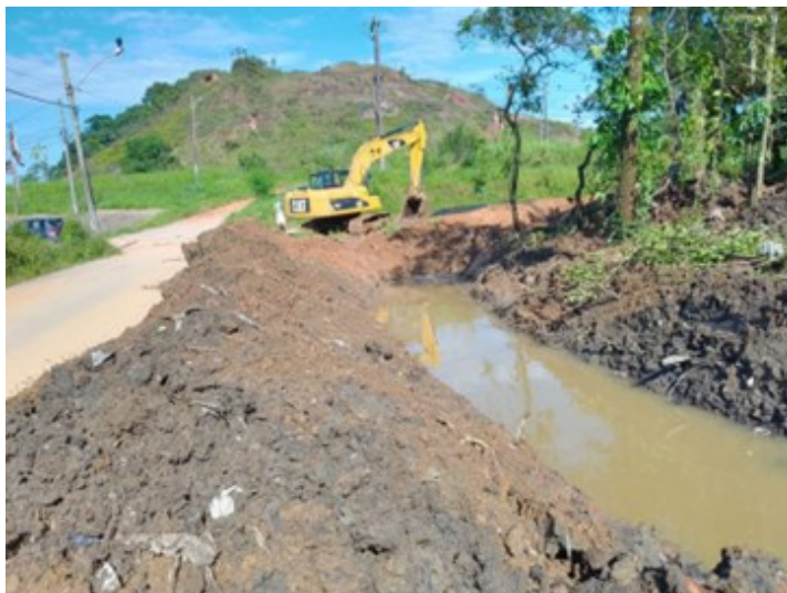
FIGURA 7-2 – DESASSOREAMENTO DE CURSO D'ÁGUA NO BAIRRO BELÉM
