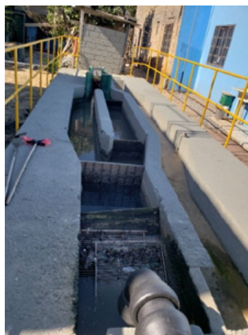
FIGURA 6-197 – ETE ABRAÃO – TRATAMENTO PRELIMINAR
