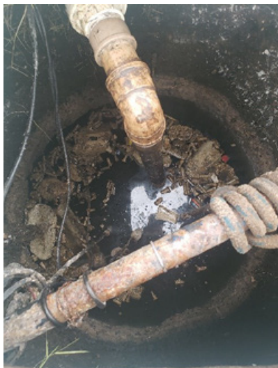
FIGURA 6-40 – EEE 04 – POÇO DE SUCÇÃO
