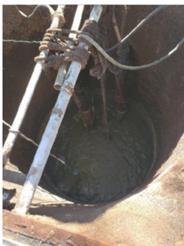
FIGURA 6-196 – EEE 02 – POÇO DE SUCÇÃO
