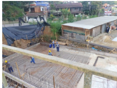
FIGURA 6-173 – OBRAS DE AMPLIAÇÃO – ETE MONSUABA
