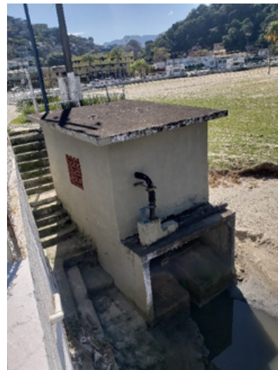
FIGURA 6-107 – EEE ANIL – VISTA GERAL INCLUINDO EXTRAVASSOR
