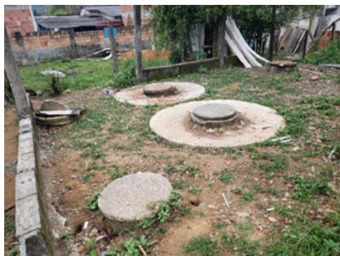
FIGURA 6-32 – SISTEMA FOSSA, FILTRO, SUMIDOURO
