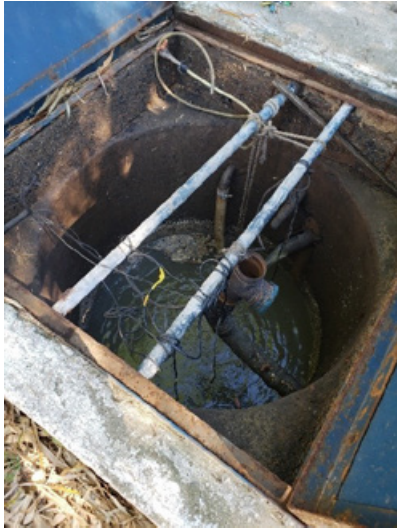
FIGURA 6-186 – EEE 05 – POÇO DE SUCÇÃO
