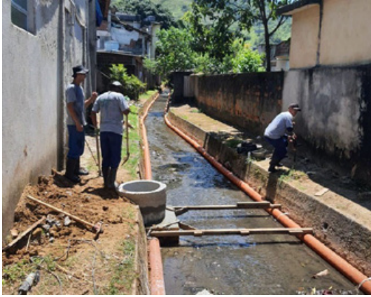
FIGURA 6-170 – IMPLANTAÇÃO DE REDE DE ESGOTO EM CANAL DE DRENAGEM Fonte: Angra, 2022.
