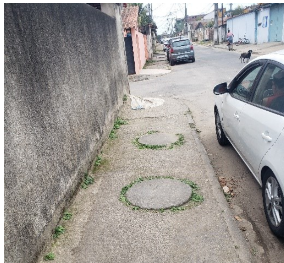
FIGURA 6-25 – SISTEMA FOSSA, FILTRO E SUMIDOURO
