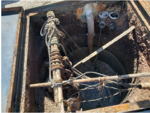
FIGURA 6-198 – ETE ABRAÃO - EEE
