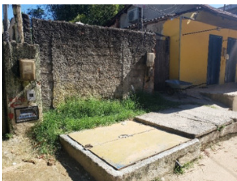
FIGURA 6-188 – EEE 04 – VISTA GERAL
