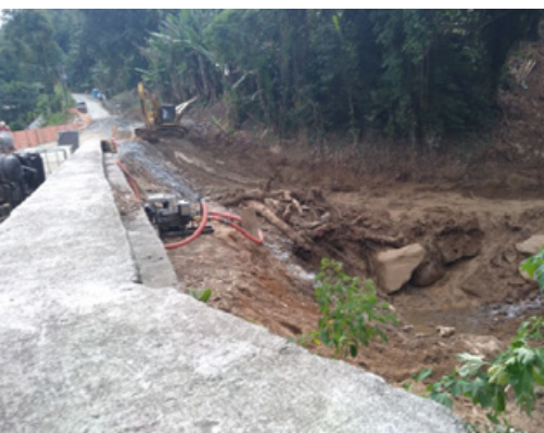
FIGURA 7-13 – OBRAS DE RECUPERAÇÃO DA ESTRADA PARA PONTA LESTE (REALIZADA PELA PETROBRÁS)
