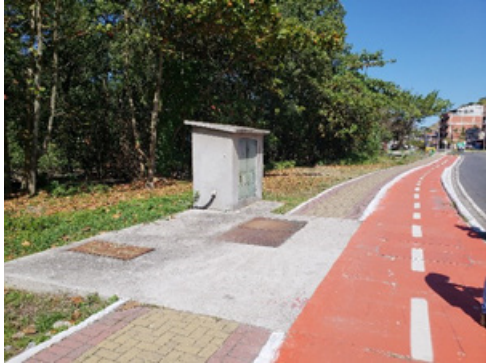
FIGURA 6-117 – EEE HOTEL – VISTA GERAL
