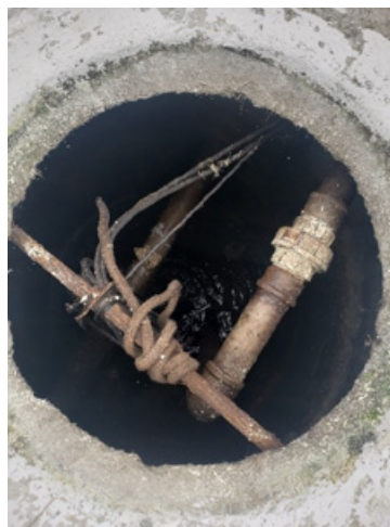
FIGURA 6-37 – EEE 03 – POÇO DE SUCÇÃO
