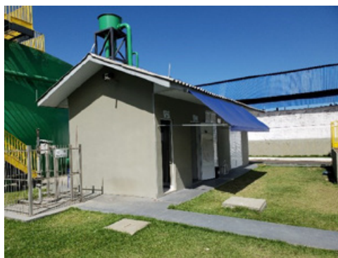
FIGURA 6-132 – ETE PRAIA DA CHÁCARA – CASA DE APOIO
