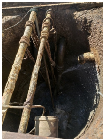
FIGURA 6-193 – EEE 03 – POÇO DE SUCÇÃO
