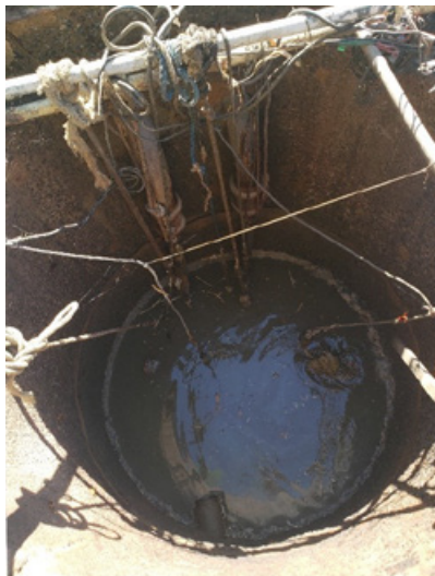
FIGURA 6-190 – EEE 04 – POÇO DE SUCÇÃO
