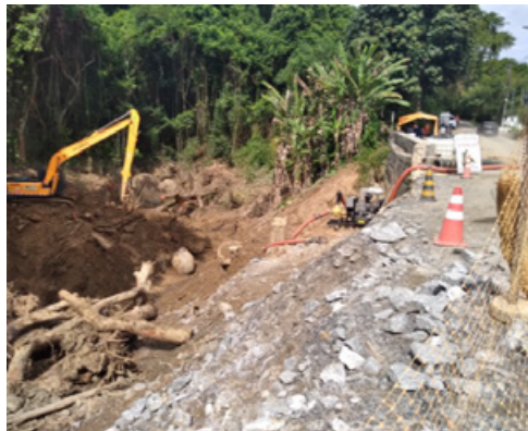
FIGURA 7-11 – OBRAS DE RECUPERAÇÃO DA ESTRADA PARA PONTA LESTE (REALIZADA PELA PETROBRÁS)
