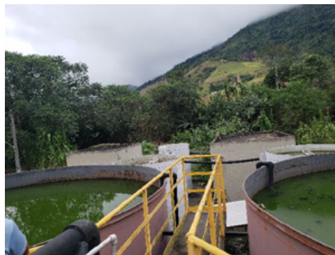
FIGURA 6-71 – VISTA SUPERIOR DOS TANQUES DE AERAÇÃO E DECANTADORES
