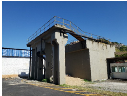
FIGURA 6-111 – VISTA GERAL DO RAFA
