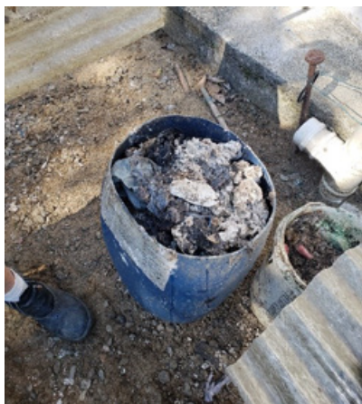
FIGURA 6-153 – ETE VILA VELHA – ESCUMA REMOVIDA DA EEE
