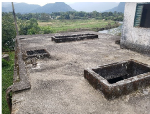
FIGURA 6-19 – ETE PARQUE MAMBUCABA – REATOR SEQUENCIAL POR BATELADA
