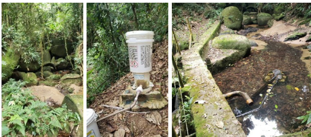
FIGURA 5-24 – BARRAGEM DE ACUMULAÇÃO DO SUBSISTEMA BARLAVENTO
