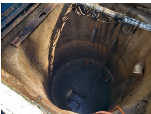
FIGURA 6-184 – EEE 06 – POÇO DE SUCÇÃO
