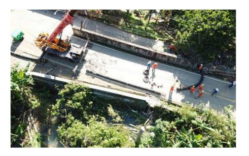
Para o trabalho de recuperação será necessário fazer um novo sistema de drenagem, para depois refazer o asfaltamento. Ainda de acordo com a avaliação inicial, é preciso também suprir de aterro as partes danificadas e refazer o muro de contenção.
