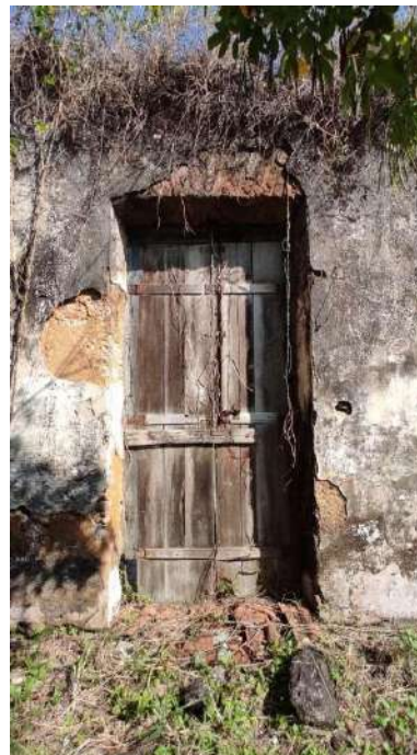
Figura 11 - vista interna porta existente
