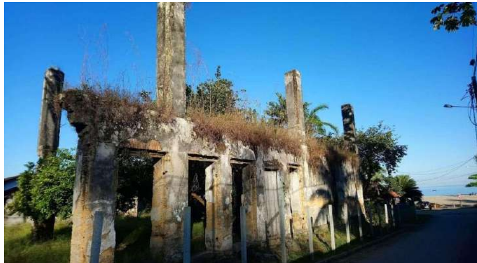
Figura 7 - fachada Rua Godofredo Domingos das Neves
