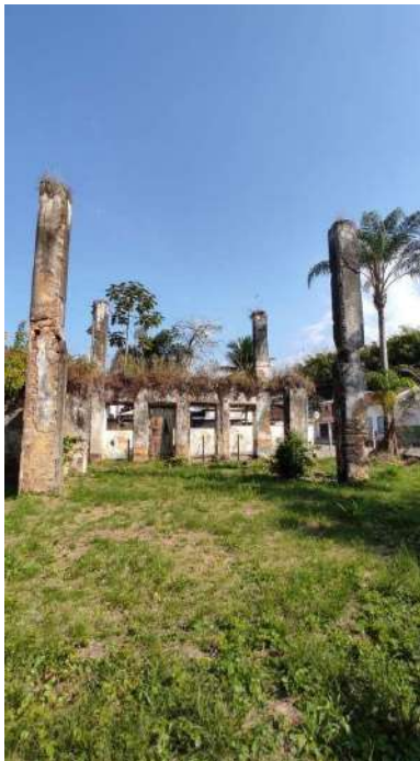
Figura 10 - vista interna porta existente
