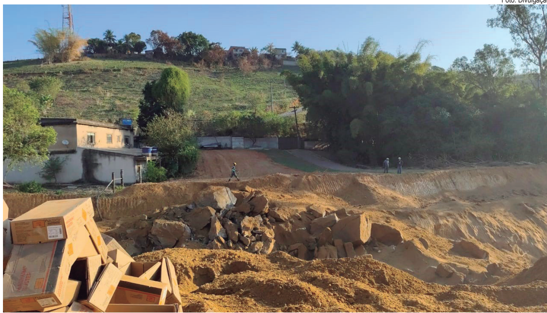
A estimativa é de que a nova detonação tenha retirado um volume total de pelo menos 1000m³ de rochas
