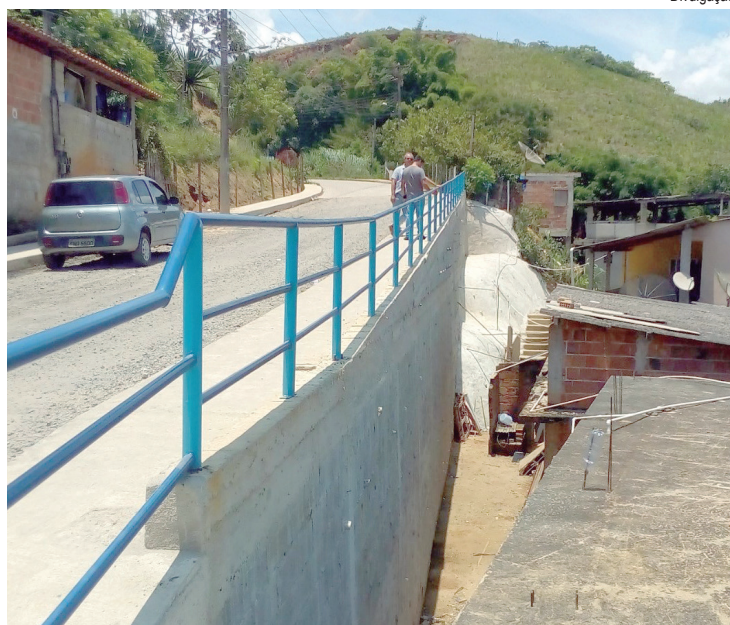
Obras são essenciais para evitar deslizamentos de terra e garantir a segurança da região
