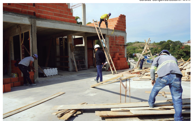
Unidade escolar está recebendo cerca de R$ 3,6 milhões em investimento
