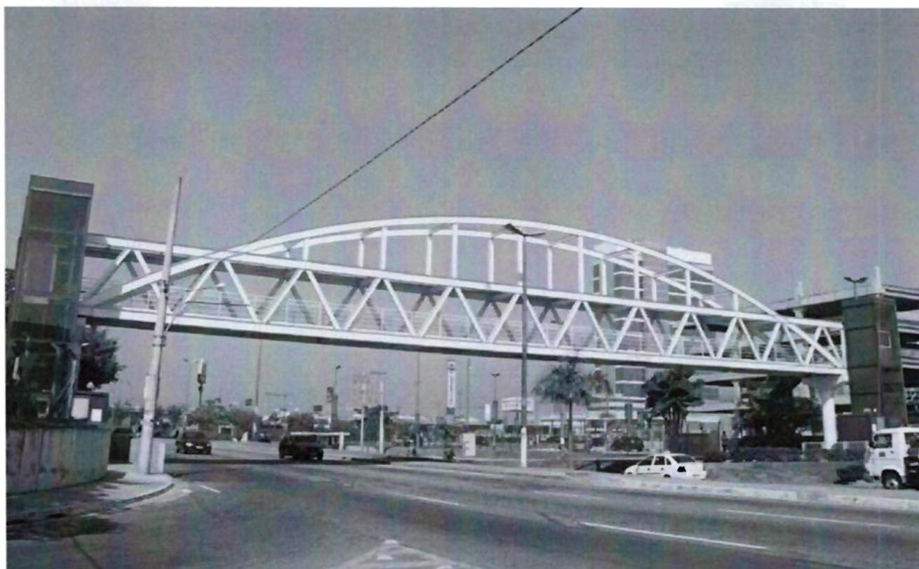
Como se pode observar nessa foto, claramente uma passarela metálica é uma estrutura metálica treliçada moldada para tal serviço.
