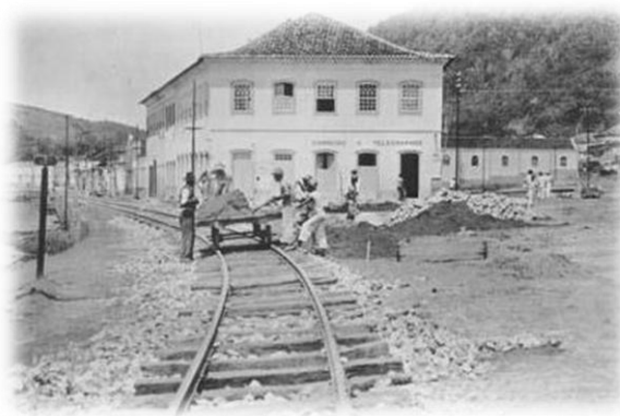
Figura 20 - Construção da linha férrea com o primeiro aterro da cidade. Data e autoria desconhecidos. Fonte: Iphan
