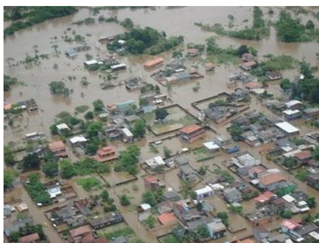
Figura 5 - Enchente no bairro Parque Mambucaba. Cena ainda muito comum em dias de chuva intensa.
