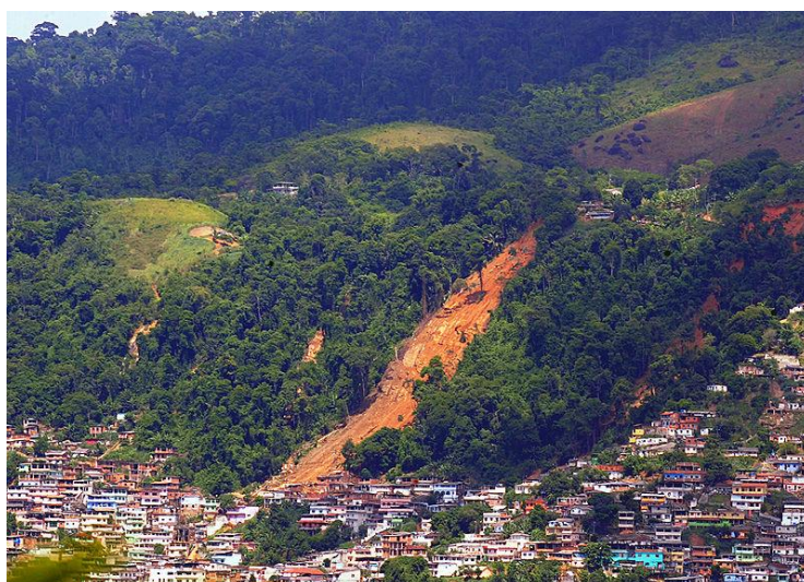
Figura 6 - Deslizamento de terra no Morro do Carmo em 2010.
