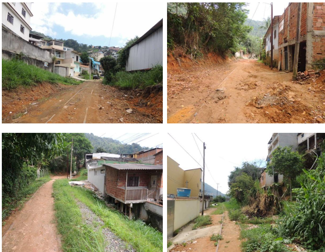
Figura 71 - linha férrea na área urbana.
