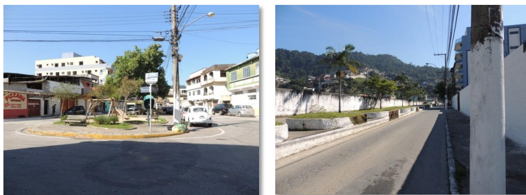
Figura 48 - Valão e muro do Estádio entre os bairros do Balneário e Parque das Palmeiras.
